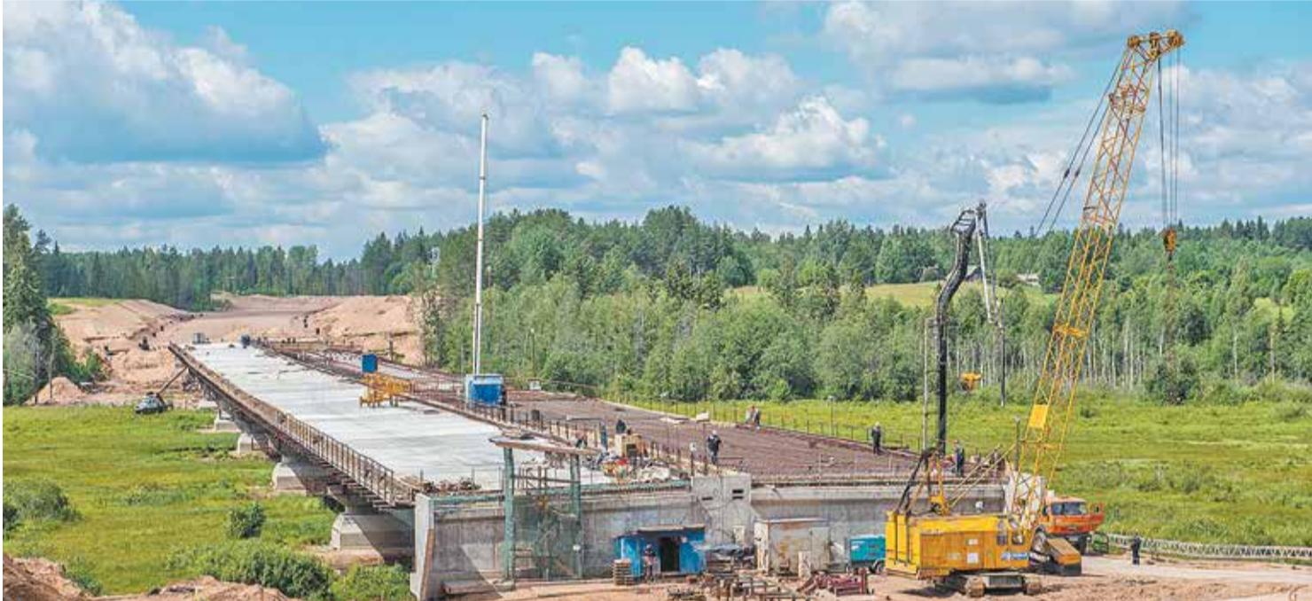
Строительство объекта «Путепровод 43-42» на шестом этапе трассы М-11
