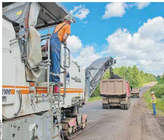
Одновременно со строительством М-11 идет реконструкция второстепенных дорог
